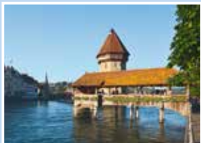
Kappelbrücke, Kanton Luzern
